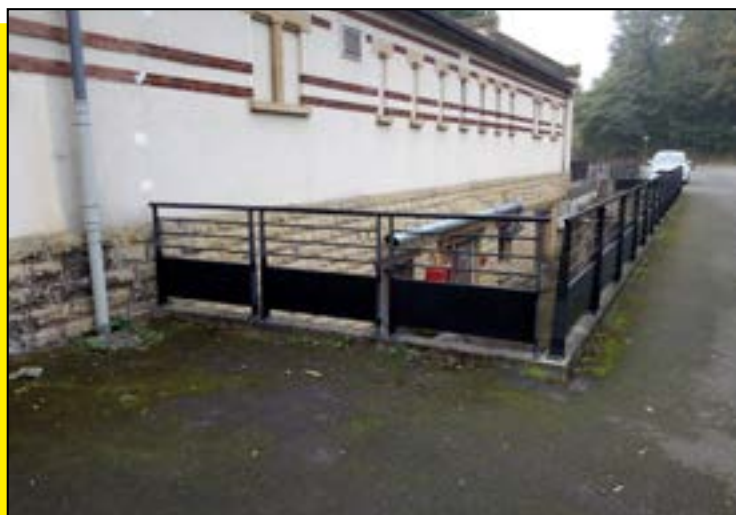
sécurisation des garde-corps - Médiathèque - Joeuf
