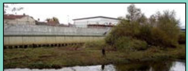
Dégagement des saules en amont du pont de Conflans : une opération techniquement compliquée
