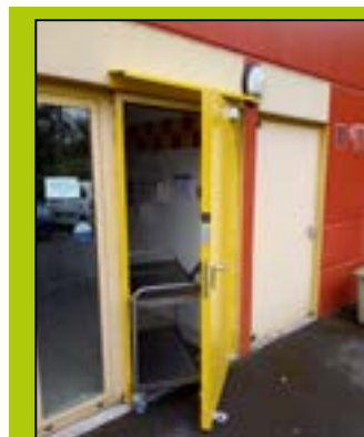
remplacement d'une porte coupe-feu Multi-accueil Pinocchio - Val de Briey
